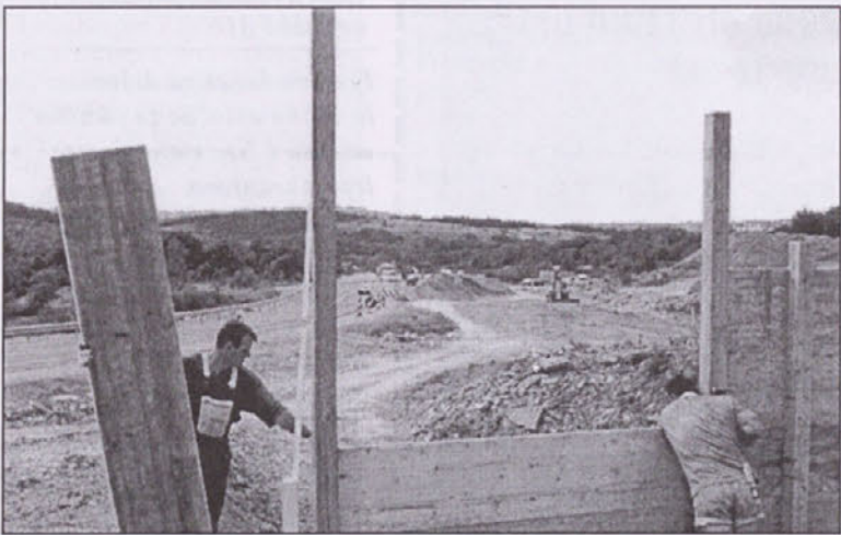
Še 20 kilometrov do Kopra Tale posnetek je bil napravljen pred kratkim - kaže delo gradbincev na trasi AC le 2 km pred vasjo Petrinje oziroma 20 km do Kopra
