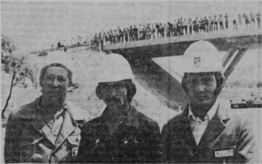
Simbol, ki mnogo pove. Trije delavci treh delovnih organizacij. Od leve proti desni: Lenart Zorko iz Gradisa, Stojan Širok, Splošno gradbeno podjetje Primorje Ajdovščina in Štefan Virag, Slovenija ceste. Trak na novi cesti je prerezal Stojan Širok.
