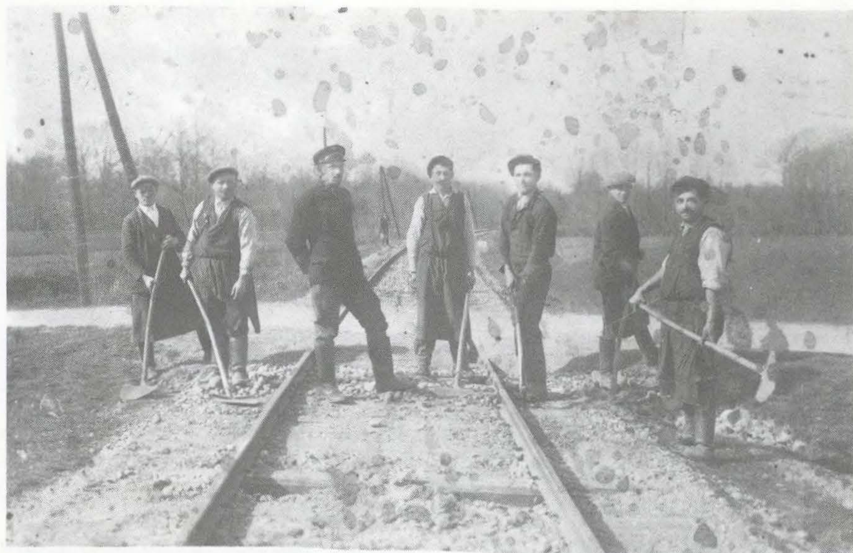
Progovni delavci na odseku železnice pri Šalincih, leta 1937
