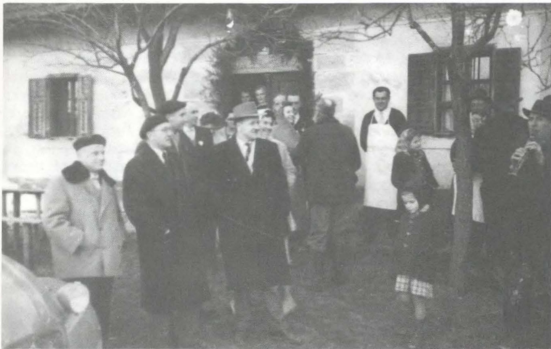
V Dobravi trdijo, da so bili pri elektrifikaciji čisto zadnji. Leta 1962 spomladi so začeli in koncem novembra so že imeli svečano otvoritev, na kateri je bil poleg drugih gostov tudi Ivan Kreft, poslanec in velik vzpodbujevalec elektrifikacije podeželja (drugi z leve). Domačin, pokojni Matej Prelog, je zapustil droben zveščič zapiskov o tem, kako so v Dobravo speljali elektriko
