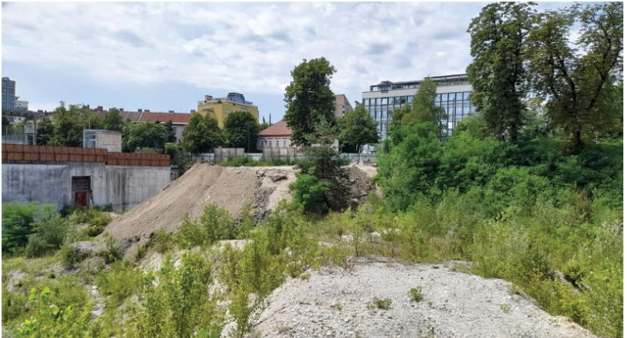
Slika 2: Pogled na jugozahodni del gradbene jame (foto: Kaja Čufer 2021).
