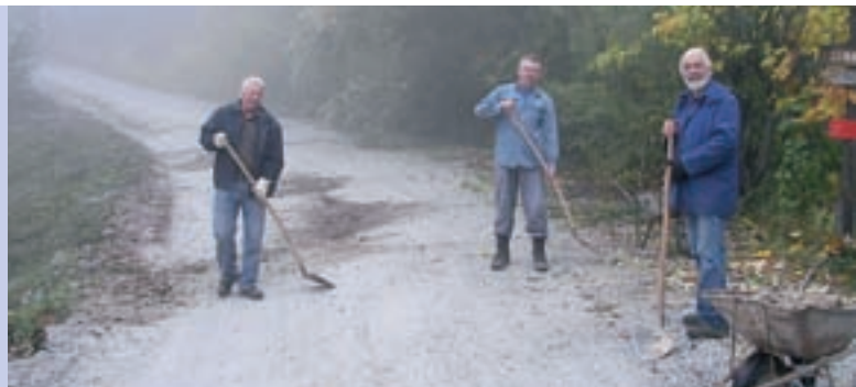
Del krajanov na Belem se je lotilo popravila občinske ceste.
