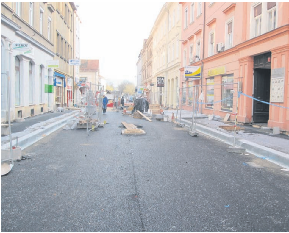
V teh dneh naj bi bila Stanetova ulica v celoti asfaltirana in tako pripravljena za polaganje tlaka, obnova pa naj bi bila končana do konca maja.
