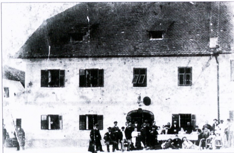
Frelihova hiša na začetku prejšnjega stoletja
