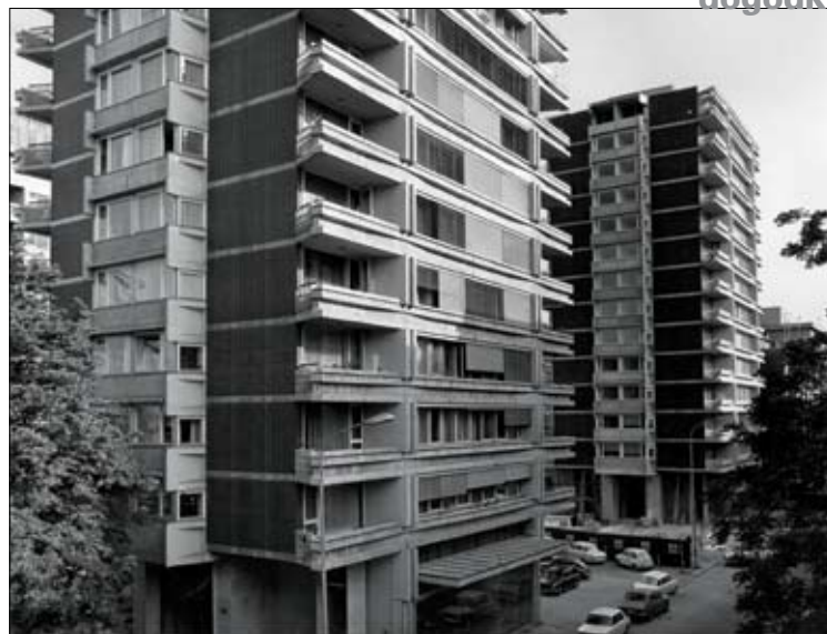
Delo Milana Miheliča ( Stanovaljska stolpnica , Ljubljana, 1969–1971) zaznamuje prefinjena delitev organske celote (Foto: Janez Kališnik)
