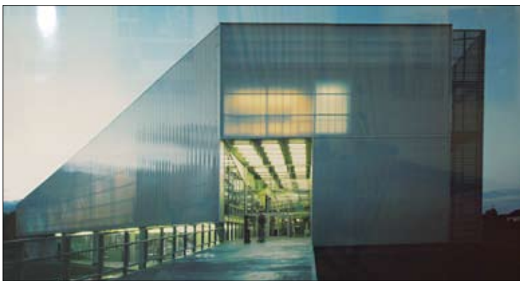
Gimnazija in športna hala, Koprivnica, Hrvaška - Studio Up
