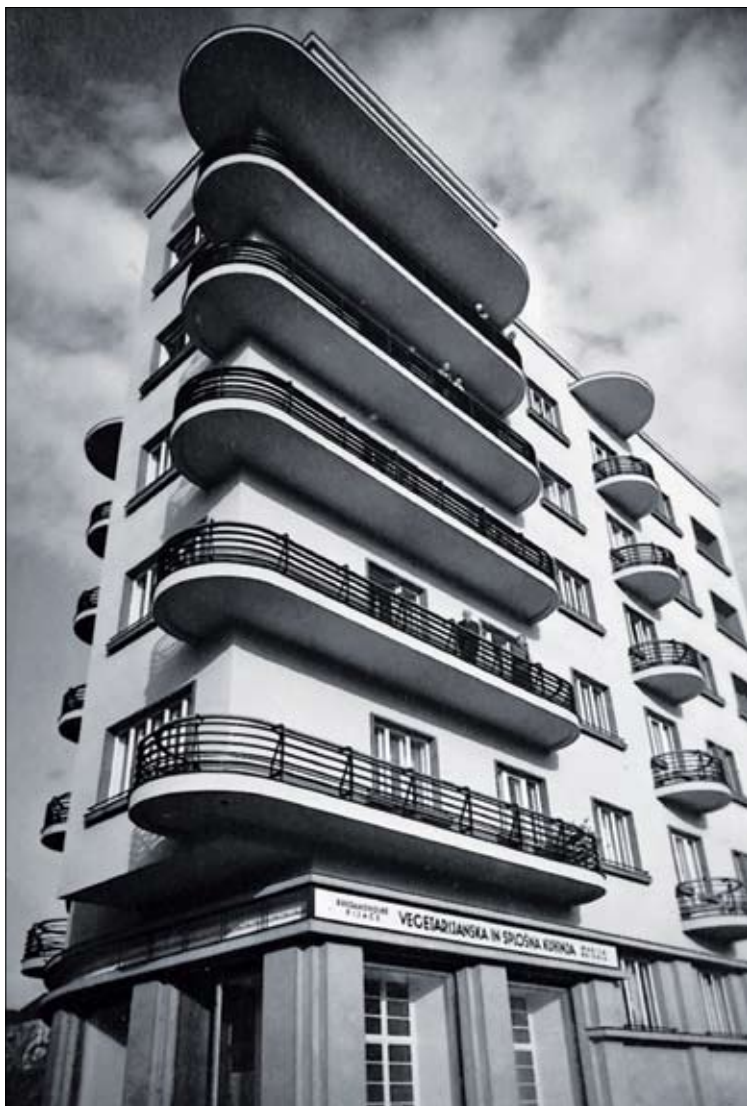
Zaradi majhne parcele je Herman Hus stanovanjem na Malem nebotičniku dodal pomole in zaokrožene balkone (Foto: Arhitekturni muzej Ljubljana)
