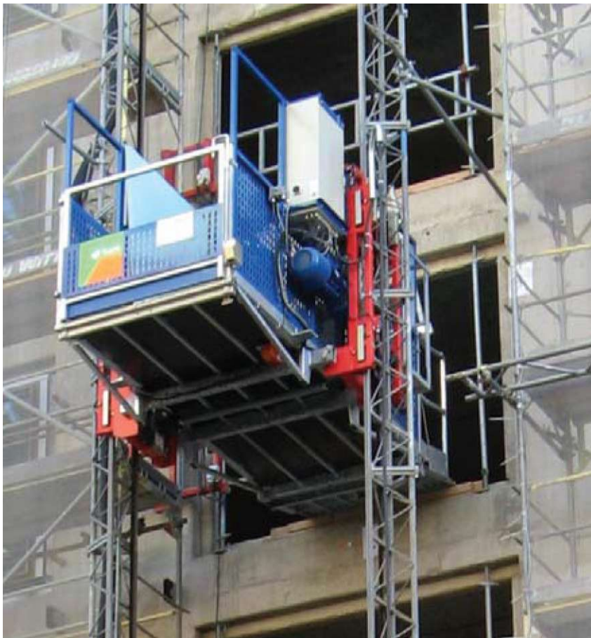
Slika 1: Na področje uporabe novega pravilnika sodijo po novem tudi začasna dvigala za prevoz tovora in oseb na gradbiščih.
