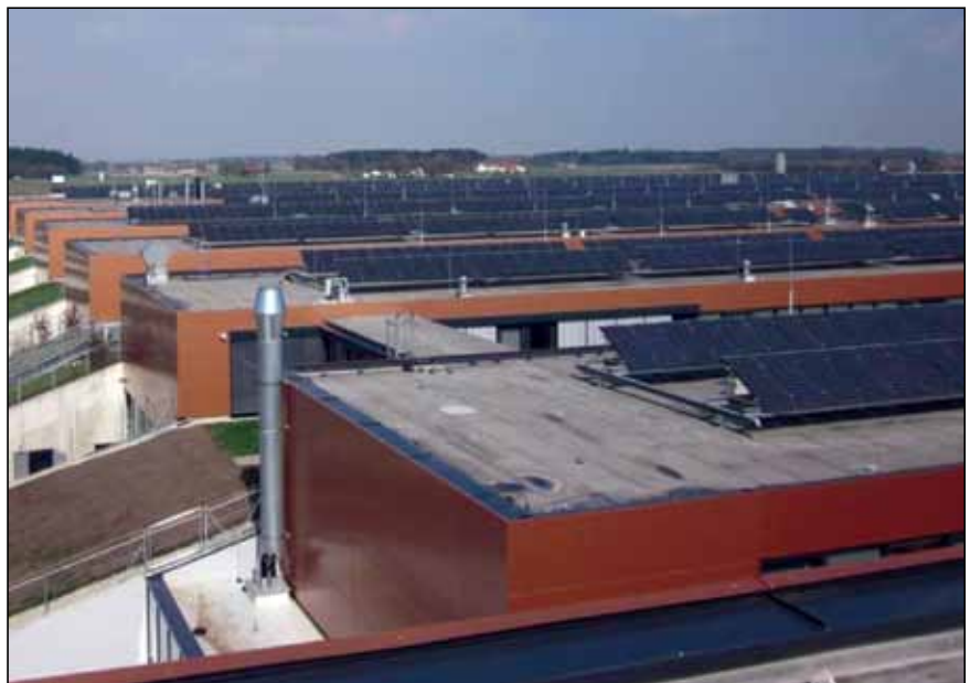
Slika 1. Nameščeni paneli s fotovoltaikami na strehi proizvodne hale
