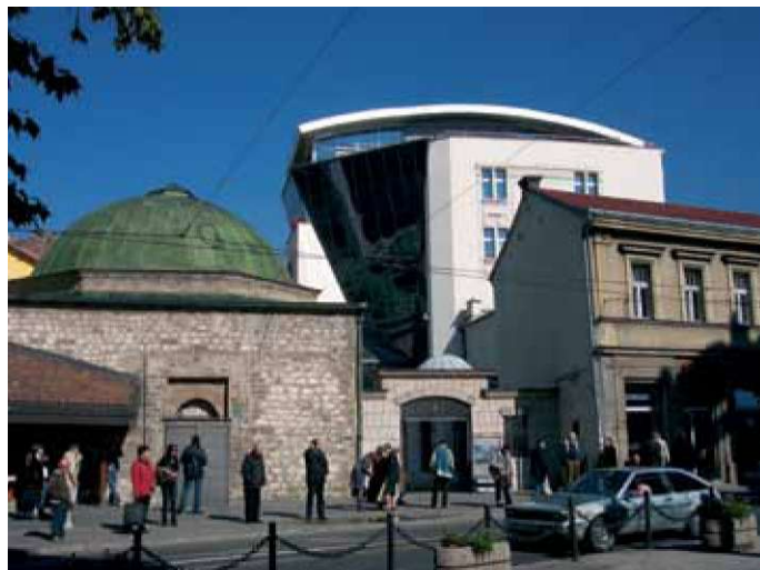
Slika 3: Nove strukture građene u stilu "falso storico" degradiraju kako stari hamam tako i cijelo okruženje. Kosa staklena ploha nije artikulirana s ostalim dijelovima ansambla. Ona odražava nedostatak temeljnih znanja i kreativnosti. Ansambl Bošnjačkog instituta upotpunjuju pseudostilski ducani dograđeni uz hamam, ograda s metalnom kapijom i turbe utemeljitelja institucije.
