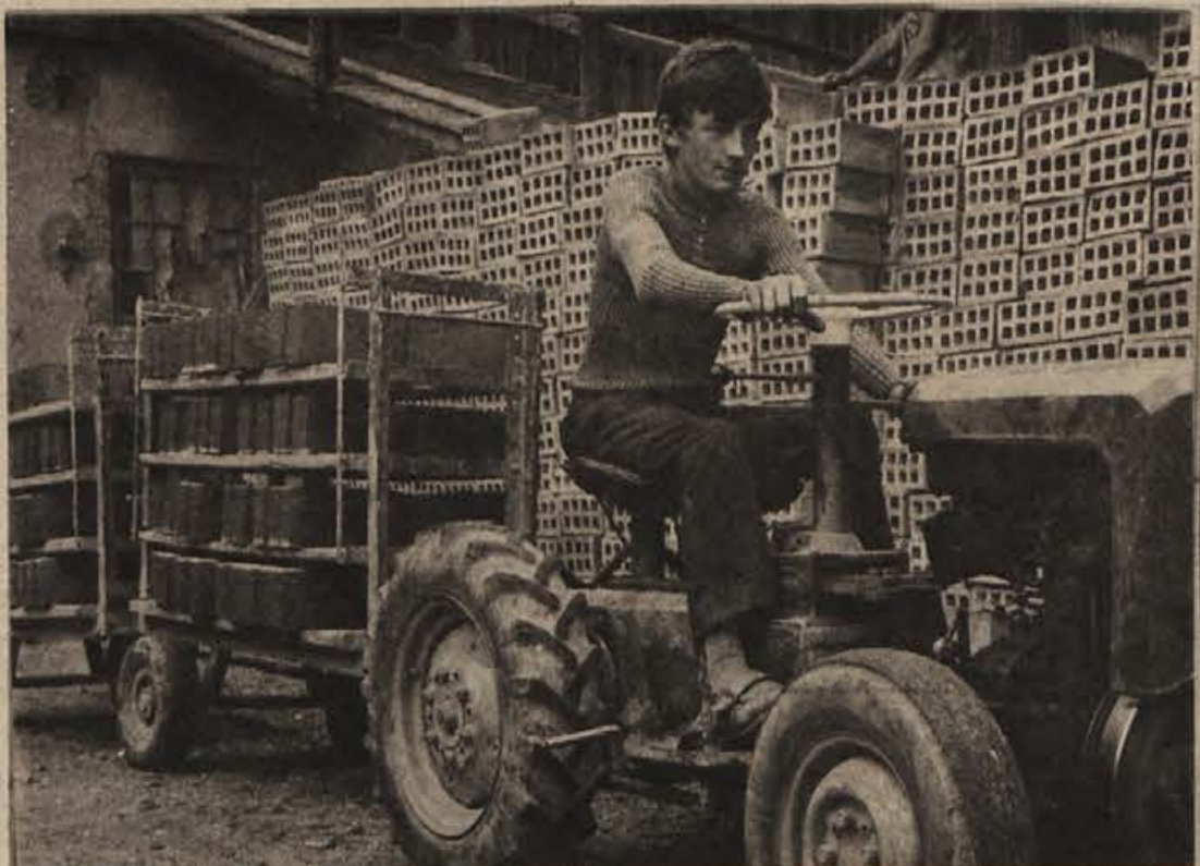
Transport svežih zidakov. (Foto: M. Vesel)
