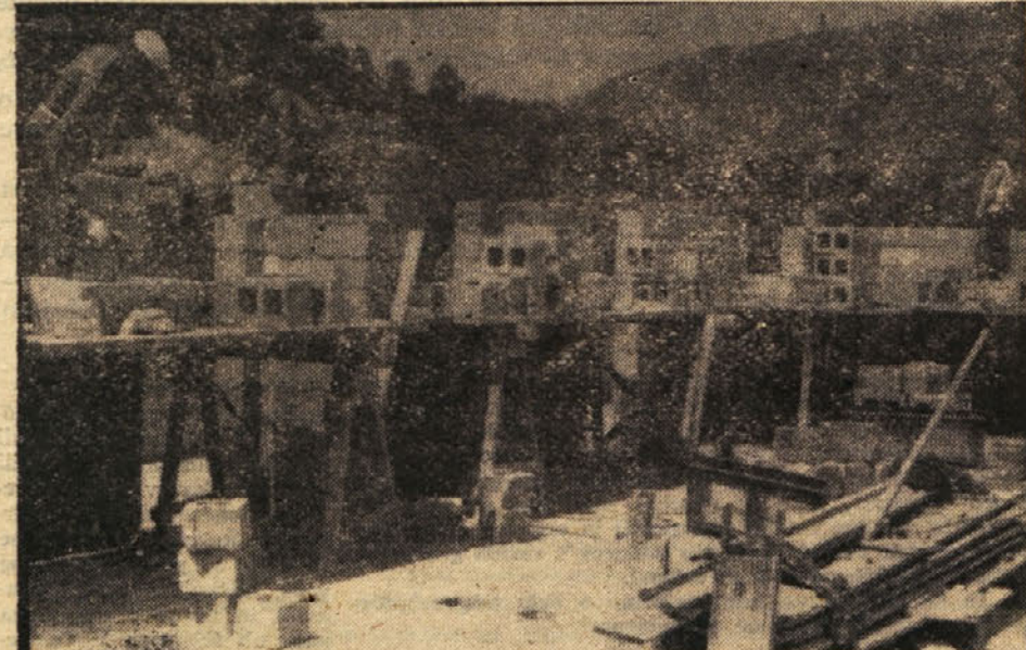
GRADBENO PODJETJE — zaključna dela na bloku VI. ob Cesti zmage
