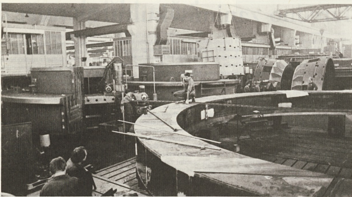
Četrty predvodilni obroč za HE Haditho je postavljen (Foto: t. š.)
