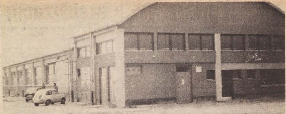
SELITEV V BOLJŠE PROSTORE — V počastitev dneva republike so v Krškem slavili več delovnih zmag, med večjimi pa so prav gotovo novi proizvodni prostori Splošnega mizarstva. Na sliki: nov objekt z 2460 kvadratnimi metri.
