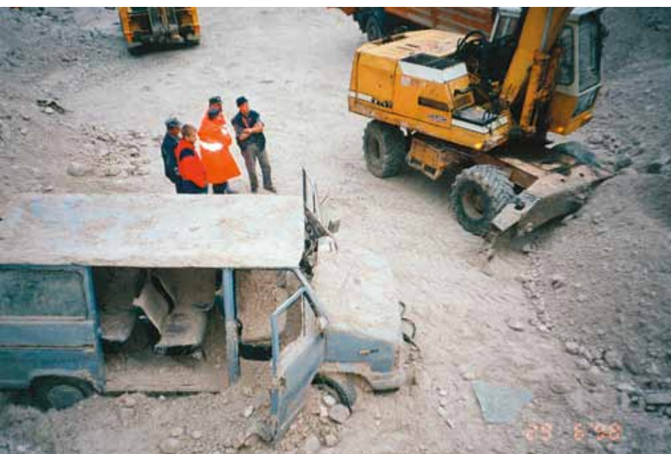
Izkopavanje zasutih avtomobilov pod Ravensko Kočno FOTO: ARHIV PGD JEZERSKO
