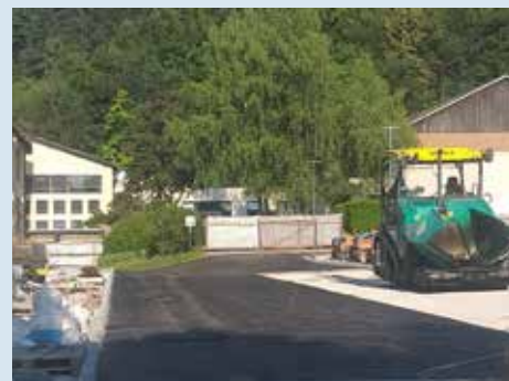
Pred Športno dvorano Mengeš se v teh dneh utrjuje teren ter polagata grobi in fini asfalt
