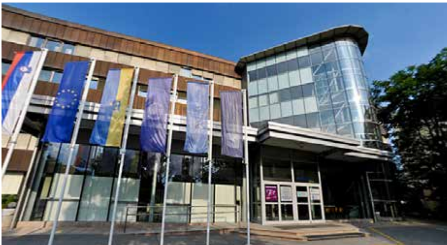
Stavba na Mariborski c. 7 v Celju, kjer imata prostore Regijsko študijsko središče in Visoka zdravstvena šola v Celju
