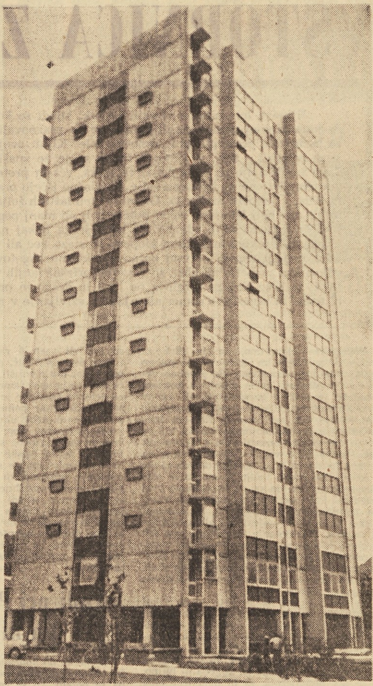
Ena izmed velenjskih stolpnic: za okna so porabili naknadno rahlo modrikasto obarvano steklo. Izkušnje kažejo, da stekla pokajo, ker se zaradi barvanja z ene strani preveč segrevajo. Predhodnih preskusov pa niso opravili. Strokovnjaki napovedujejo, da bo treba stekla v celoti zamenjati bodisi z navadnim, bodisi v monolitno obarvanim steklom. Skratka — malenkost, ki bo precej draga...
