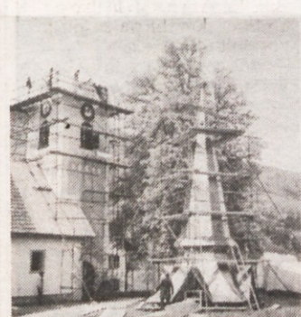
POSODABLJAJO CERKEV - Kakor drugod po Sloveniji in Dolenjski tudi na Kočevskem posodabljaajo cerkvene objekte. Tako so tudi na cerkvi v Livoldu stari pločevinasti zvonik zamenjali s sodobnejšim in trajnejšim bakrenim. (Foto: J. Primc)
