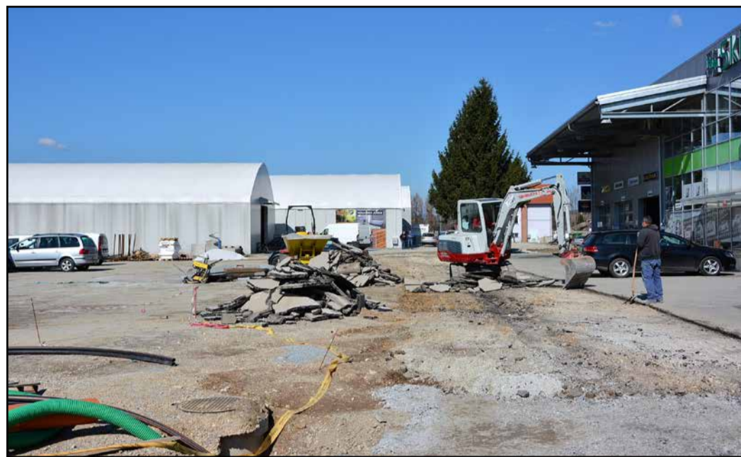
Pri dokončanju kraka kanalizacije na Groblji
