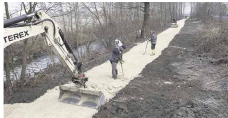
Gradnja pešpoti ob Rači
