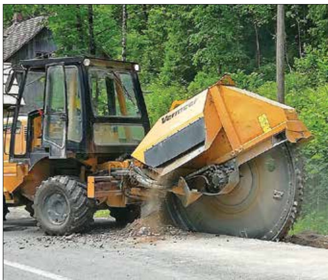
Na Solčavskem s posebnim strojem frezajo del cestišč in v zemljo polagajo večžilni kabel. (Fotodokumentacija Mateja Coklina)
