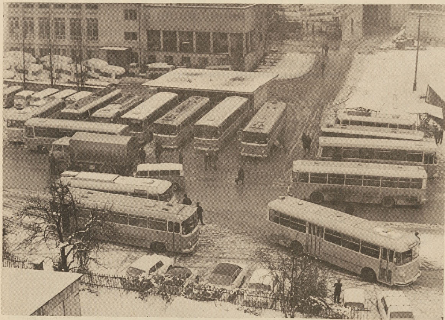
Staro postajališče (na fotografiji) je bilo nevarno za promet in za delavce.
