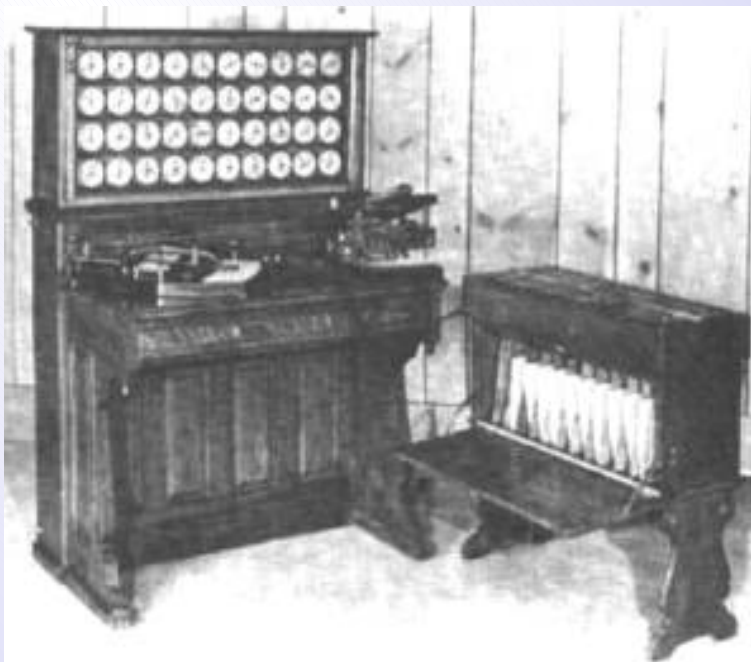
Slika 2.5: Elektromehanska naprava krmiljena s preluknjanimi karticami
