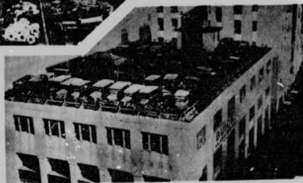
Avtogaraža na strehi.
