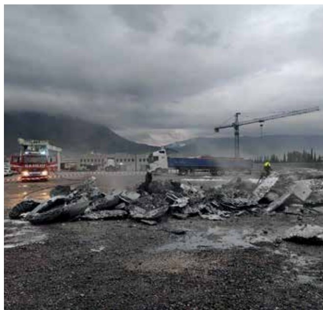
Slika 2: Pogled na požarišče
