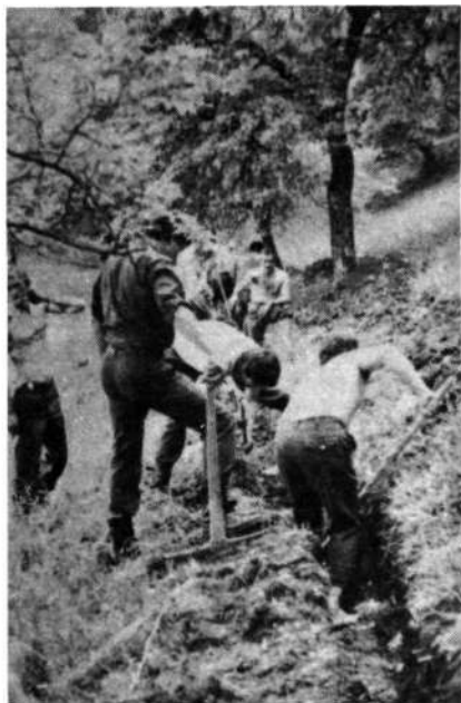
Mladi na usposabljanju v enotah TO: Izkop vodovodnega jarka v prostem času.
