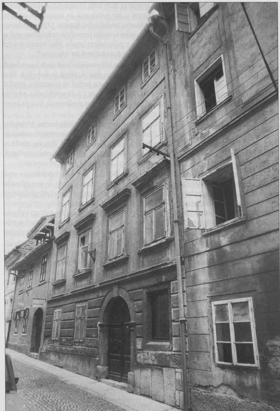
Hiša v sredini - Križevniška ulica 3. (Foto M. Zaplatil, 1991. Fototeka Mestnega muzeja Ljubljana) • The house Križevniška 3. (Photo by M. Zaplatil, 1991. Ljubljana City Museum) • Maison au milieu - Križevniška ulica (rue) 3. (Photo prise par M. Zaplatil en 1991. Photothèque du Musée de la ville de Ljubljana).
