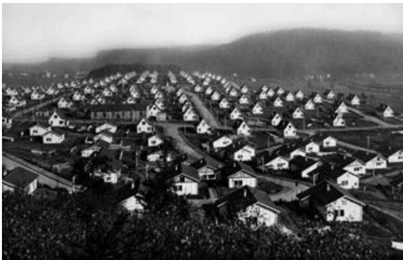
Rudarsko naselje, ki ga je Alojz Gričar iz Merlebacha opisal z naslednjimi besedami: »Po vojni narejeno iz samega železa, betona in nobenega lesa, zraven je vse v tovarni narejeno in tukaj je skupaj postavljeno. Povsod je centralna kurjava in precej velik vrt.« (arhiv SIM).
