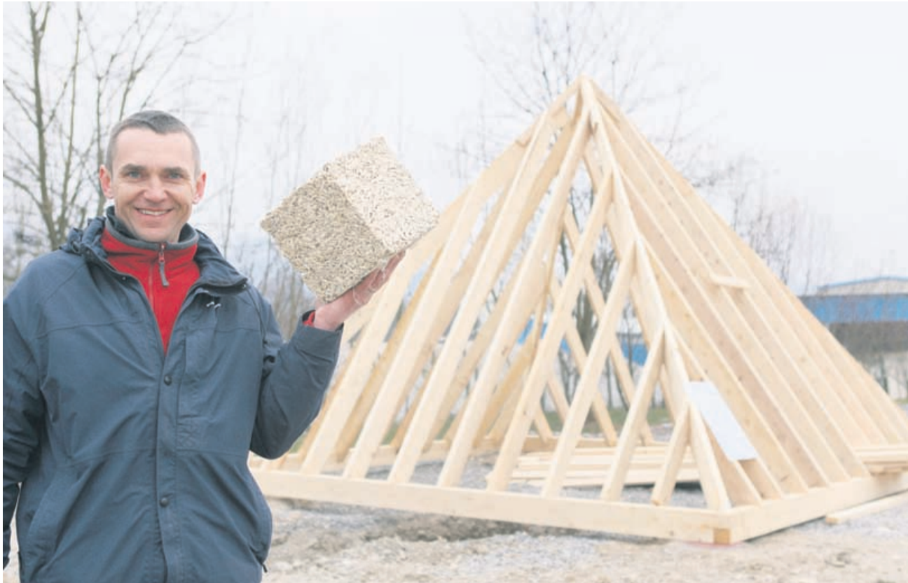
Bout Šket bo leseni skelet v prihodnjih dneh prekril z zidaki iz konoplje in pokazal, da se da graditi iz tega materiala.
