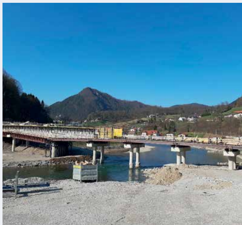
Izvedena je že desna stran grede (april 2020)
