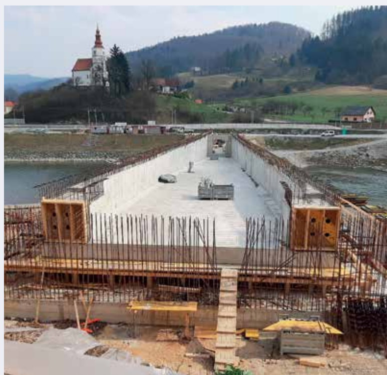
Prečni prerez desne prekladne konstrukcije (marec 2020)
