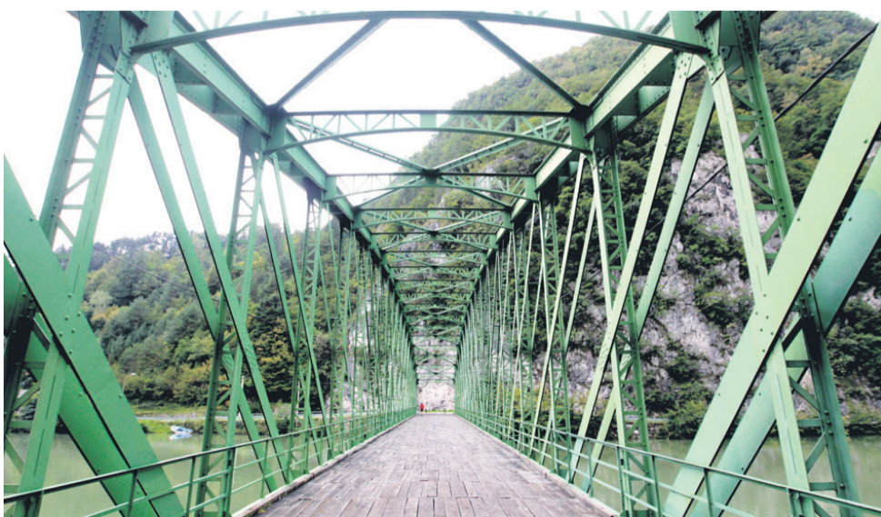
Železni most čez Savo so začeli graditi septembra 1893 na pobudo krajanov, ki so želeli povezavo med tedanjima sosednjima pokrajinama Štajersko in Kranjsko, Mavricij Scheyer pa je bil načelnik mostnega odbora, danes bi lahko rekli, da je opravljal naloge menedžerja. Celotna konstrukcija mostu je izvedena kot paličje oziroma predalčje iz valjanih železnih profilov. Vsi spoji so med seboj kovičeni. Vozišče je bilo narejeno iz hrastovih plohov. Most je dolg 84 metrov, širok je šest metrov in ima nosilnost 12 ton.
