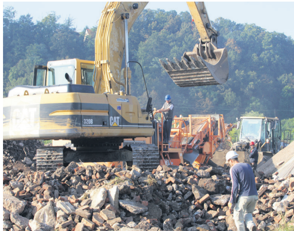
Iz zemljine izločene večje vključke betonskih ruševin je treba razdrobiti po posebnem postopku, saj bi drobljenje s hidravličnimi kladivi povzročalo preveč hrupa.
