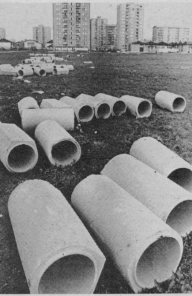
Značilna podoba novonastajajočih naselij. Vedno večje potrebe po pitni vodi pa tudi po urejanju kanalizacije. Vse okrog čiste vode pa je v zvezi z odplakami in zaščito vodnih virov.
