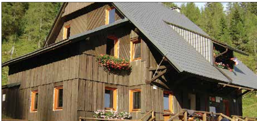
Koča na Loki ima svoj fotoelektrični sistem oskrbe z elektriko in ekološko čistilno napravo. (Fotodokumentacija PD Luče)
