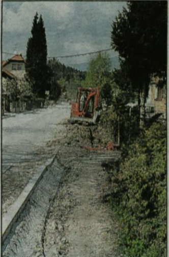
Nadaljujejo se tudi dela pri gradnji pločnika in sanaciji cestišča na VII. ulici.
