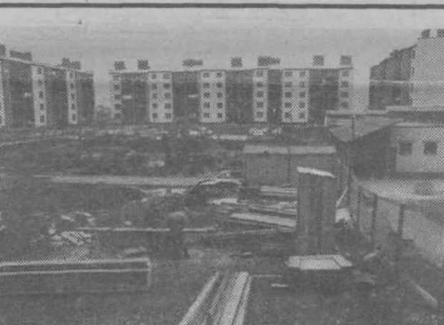
Gradnja prizidka k vrtcu v Novih Jaršah
