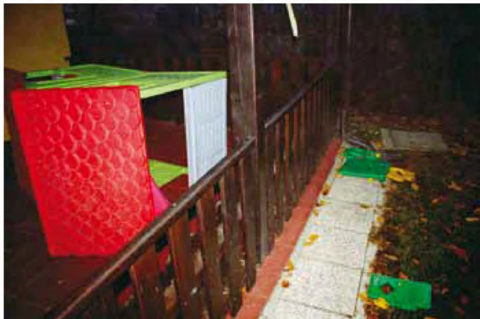
Posledice vandalizma pred stavbo vrtca Beltinci.
