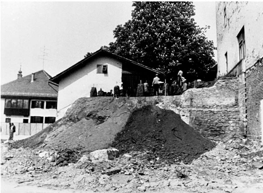
Sl. 2: Hotel v Ormožu. Sektor 1. Ostanek prazgodovinskega okopa po odstranitvi stavb; pogled z vzhoda.
