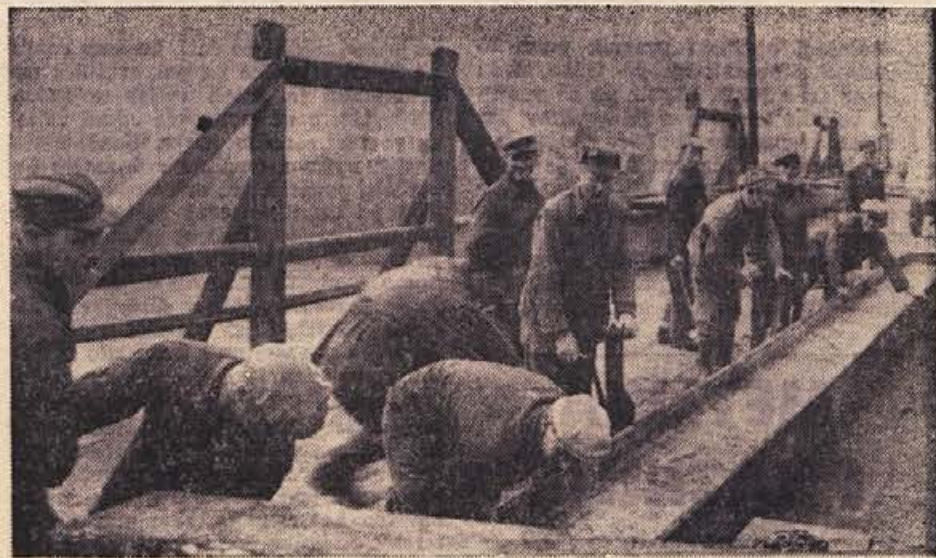
Takole smo srečali delavce na starem krškem mostu pretekli četrtek zjutraj v megli: obnova dotrajalega mostu je vendarle stekla!
