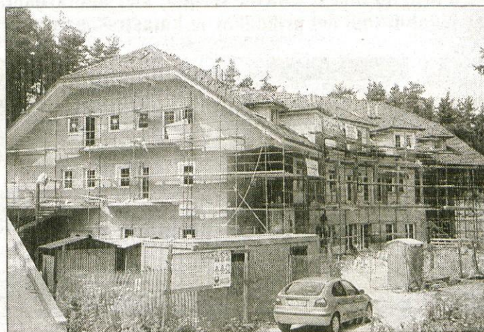
Gradnja večstanovanjske stavbe na Mlaki pri Kranju.
