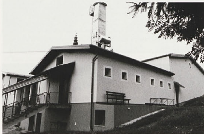
Energetska sanacija telovadnice OŠ Cirkulane, ki je hkrati tudi večnamenska dvorana, vrednost investicije 137.509 evrov.
