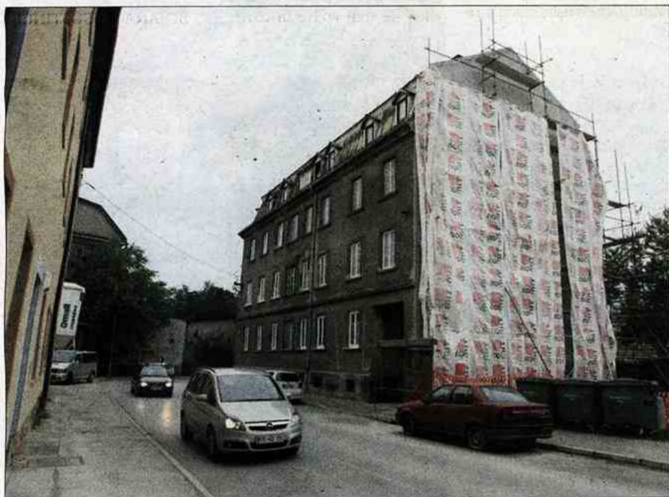
Severno steno »ekhaus« so že pokrpal in ometali, zdaj je na vrsti stena z dvoriščne strani. Obnova fasade bo stala 7.500 evrov, precej večji finančni zalogaj bo obnova strehe, ki naj bi prišla na vrsto spomladi.
