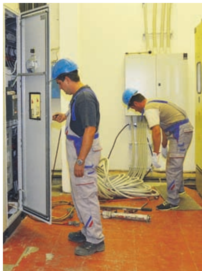
V programu pralno-sušilnih aparatov so obnovili transformatorsko postajo, tako srednje kot tudi nizko napetostno postrojenje.
