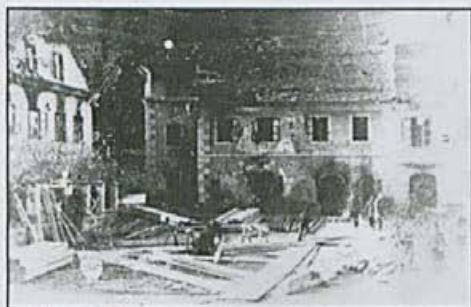
Izdelava zasilnega ostrešja za cerkev, januar 1945.
