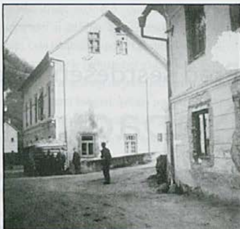
Utrjena postojanka v prosvetnem domu.
