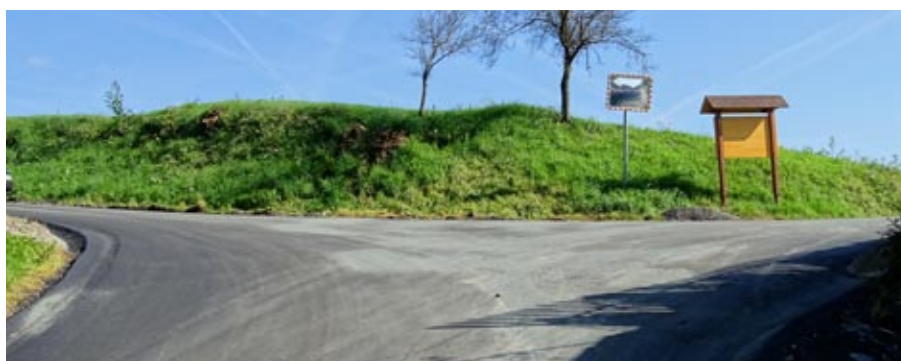
Asfaltiran odcep Kobošak
