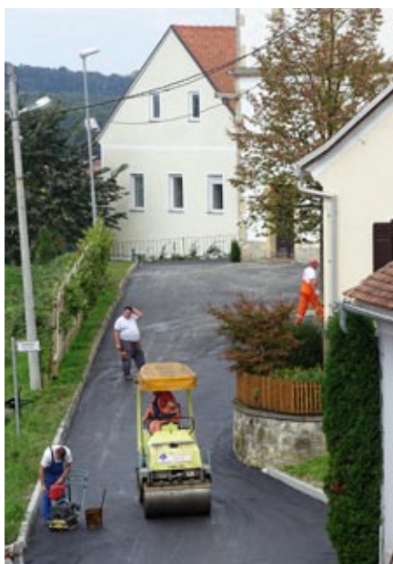
Asfaltiranje trga pred cerkvijo
