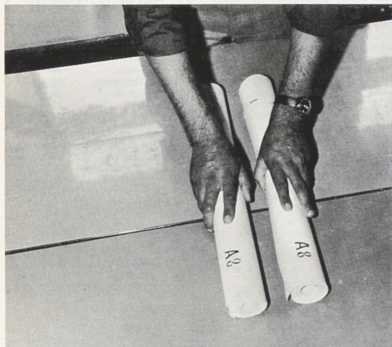
Sl. 1: V istem prostoru morajo biti položene tapete z enako izdelavno številko
