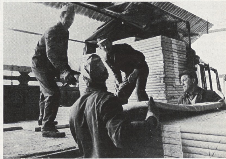
Nakladalec gotovega blaga bo olajšano delo s postavitvijo novega skladišča in nakladalno rampo (Količevo)
