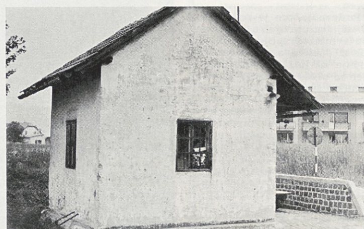
»Pogled skozi okno« pri vagonški tehnici na Vevčah. Z malo stroškov bi bil ta pogled precej lepši
