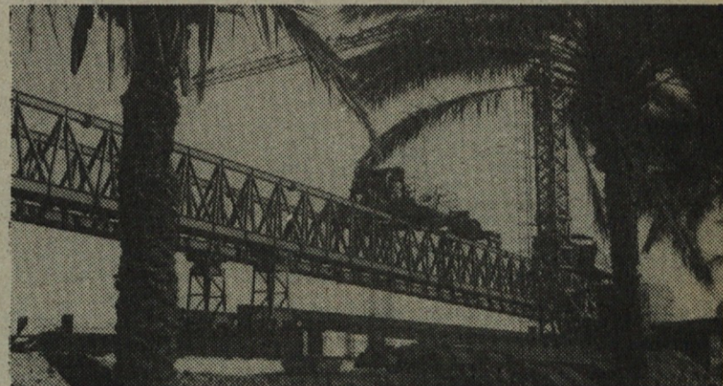
Konstrukcija za montažo nosilcev je pripravljena za pričetek glavnih del, priti bo treba še na drugi breg
