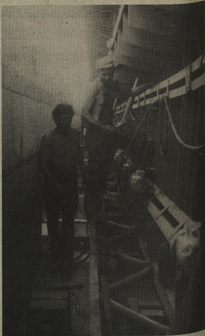
Od dela v kuhinji, plovbe po Tigrisu in težaškega dela na pontonih — do najpreciznejšega dela na opažu in napanjanju sta opravila delavca Potočnik in Bratušek
