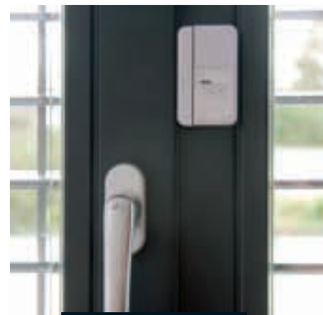
Montaža tipala na okno
