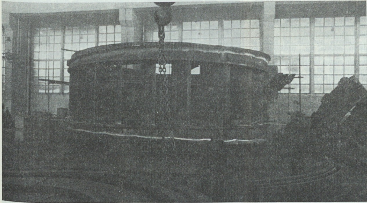
Predvodnik za HE Grabovico po velikosti ni redek izdelek delavcev te proizvodne hale (Foto: K. G.)
